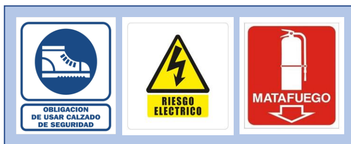
Figura 1: Cartelería de seguridad ubicada en la sala de caldera
