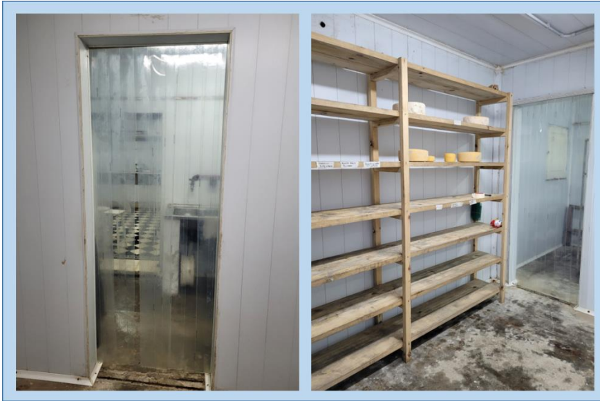
Figura 2: Instalaciones con paredes lavables y cortinas plásticas.
