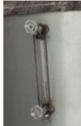
Figura 4: Representación de nivel de agua de la caldera de 700L.
